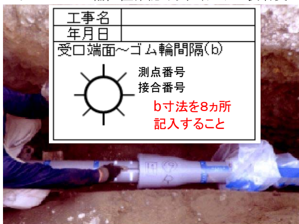
写-1 ゴム輪位置確認写真（ライナ装着受口への挿入）
