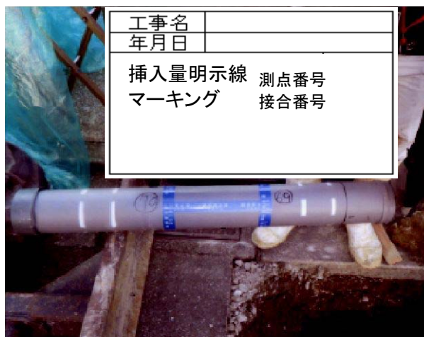
写-4 挿入量明示(マーキング)写真
