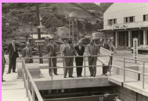
上町浄化センター通水式 1966 年
