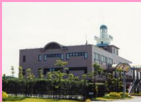
西浄化センター
