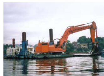
バックホウしゅんせつ船によるしゅんせつ作業
