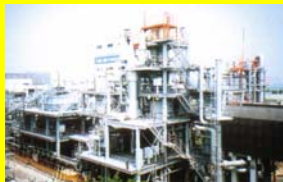
下町浄化センター (汚泥焼却炉)
