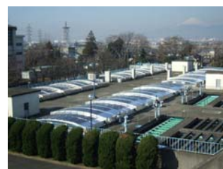
太陽光発電設備
